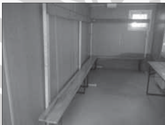
Die Rasenfläche wurde um die Flutlichtmasten erneuert (oben), neue Container dienen den Teams jetzt als Umkleidekabinen.
