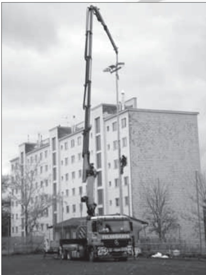
Neue Flutlichtmasten werden am Rasenplatz aufgestellt
